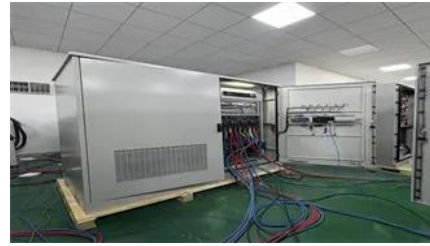
Sol-Up Solar , Premier Las Vegas Solar Provider
