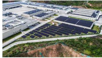
Sol-Up Solar , Premier Las Vegas Solar Provider
