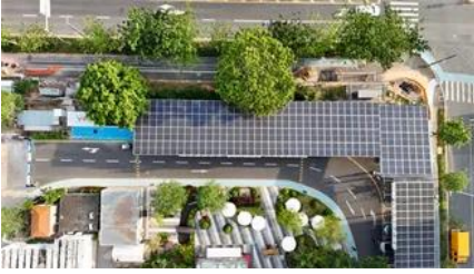
Sol-Up Solar , Premier Las Vegas Solar Provider
